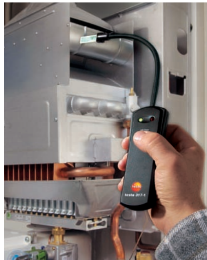
Рис. 17: Использование детектора утечек для контроля обратной тяги
