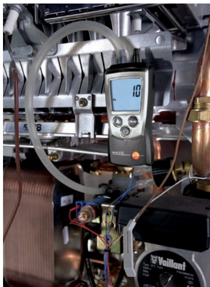
Рис. 9: Проверка давления в газовых магистралях с помощью testo 510
